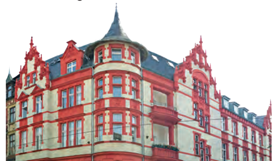
Kerwien's Privathausbau, Stiftstr. 8 / 8a, Foto: A. Looft
