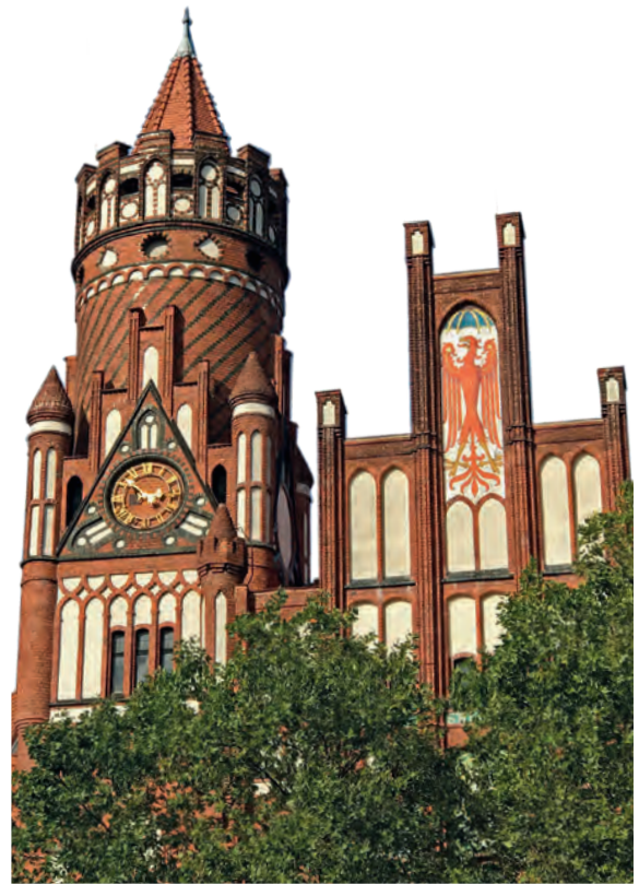
Foto: Rathaus Schmargendorf, märkische Backsteingotik, Kerwienbau fertiggestellt im Jahr 1902 (A.Looft)
