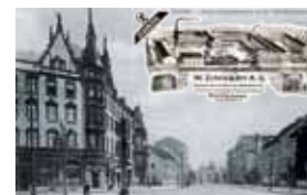
Zinnert Wohnhaus Holzmarktstr. / Ecke Berliner Str., hofseitig befindet sich die Zinnert Konservenfabrik (nicht mehr existent)
